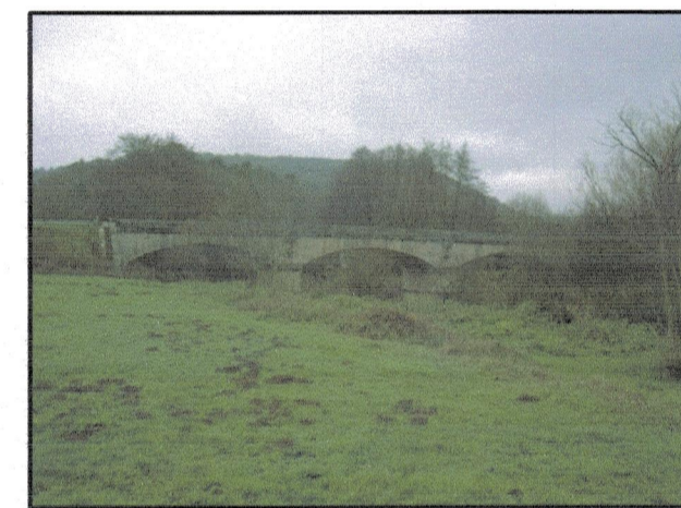
Pont de Blannay (RD 951)
